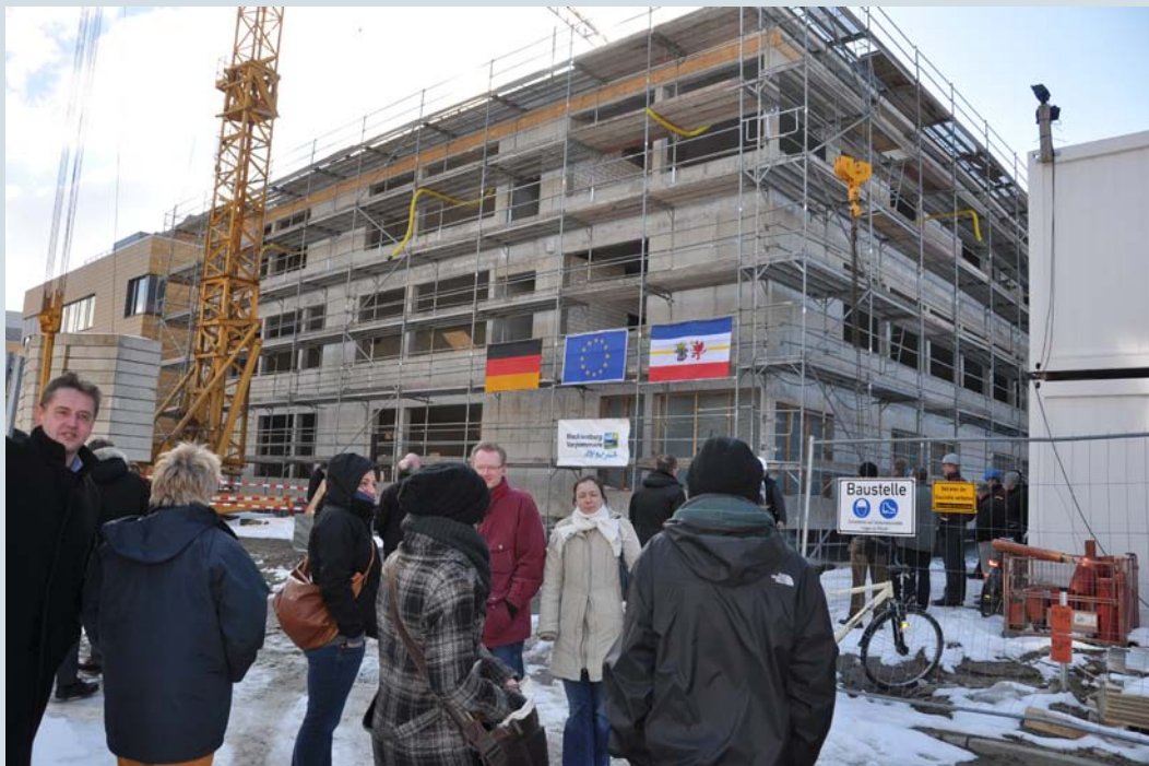
Bild: Ansicht des Rohbaus (und der Richtfest-Feiernden) von der Nordostseite (Jahnstraße)
