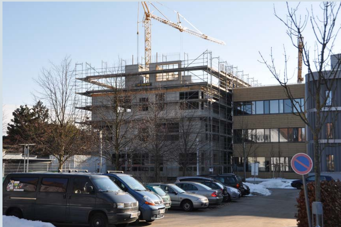
Bild: Rohbau von der Westseite (Parkplatz Biotechnikum)
