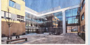
Der Neubau des Laborgebäudes besteht größtenteils aus Glas. Der Innenhof soll den etwa 60 Mitarbeitern ein Erholungsort sein.
