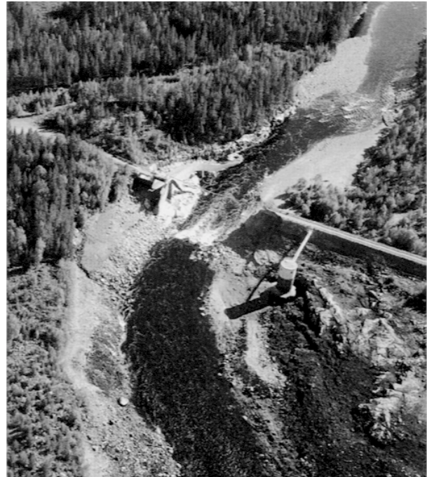
Bild 1.3: Der Noppikoski-Damm brach im September 1985 aufgrund eines extremen Herbsthochwassers (aus: NATIONAL ATLAS OF SWEDEN, CLIMATE LAKES AND RIVERS, p.161).
