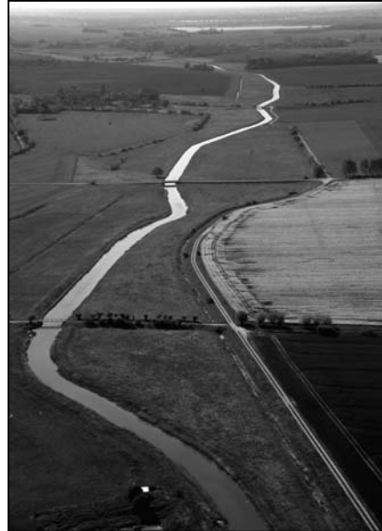
Taf. 3b: Barthelauf zwischen Divitz und Wobbelkow, Blick von Nordwesten (Schrägluftaufnahme). Ausgebauter Flußabschnitt.
