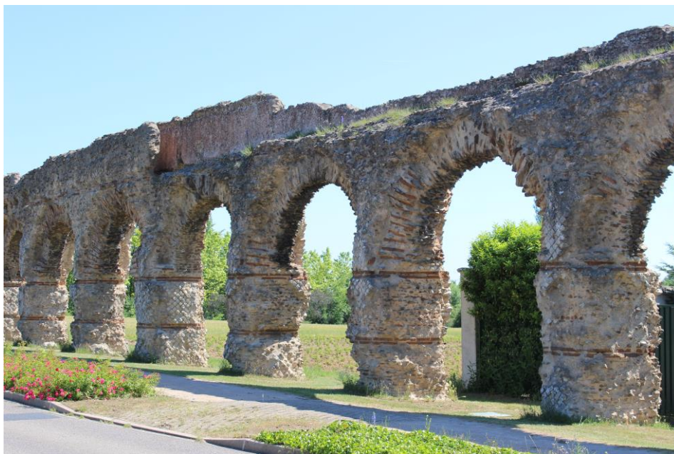
Aquädukt Gier bei Lyon; Photo: Egetenmeyr
